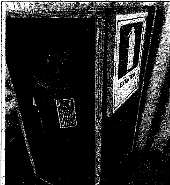
Fotografía N° 1, extintor de incendios con mantención vencida. 25 de abril de 2017.
